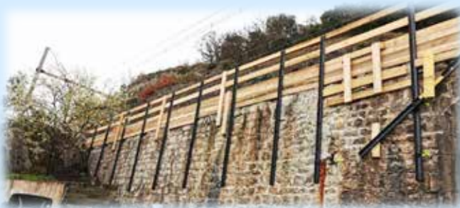
Travaux de soutènement
