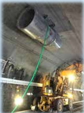
Pose de ventilateurs en tunnel
