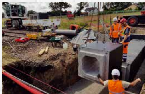
Travaux de génie civil
