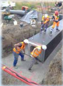
Réalisation d'ouvrage sous voie
